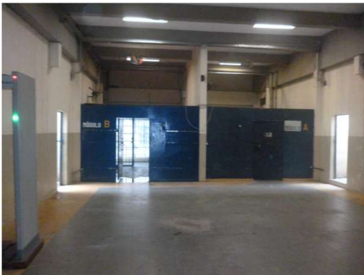
Foto 1: acesso aos módulos A e B
