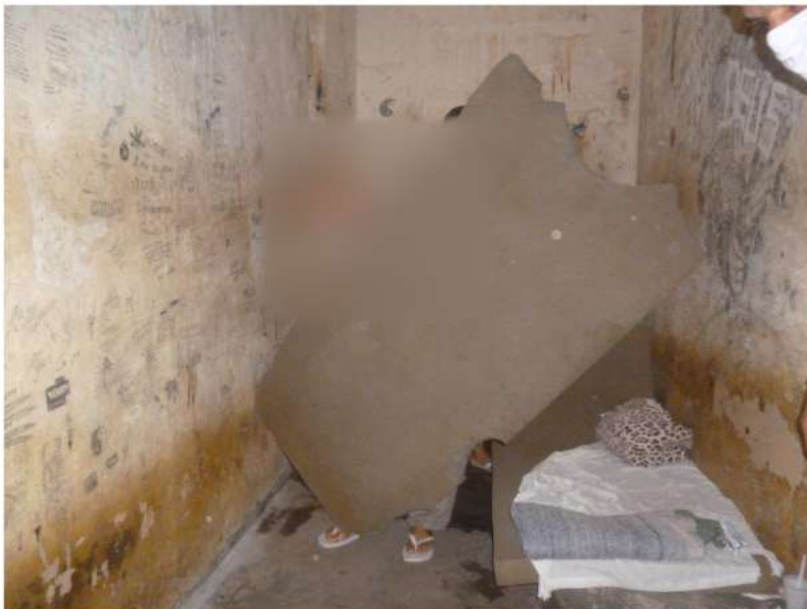
Foto 5: estado de conservação do colchão da cela de castigo
