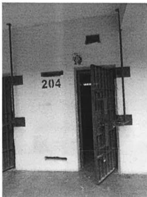
Imagem 3: porta automatizada de cela
