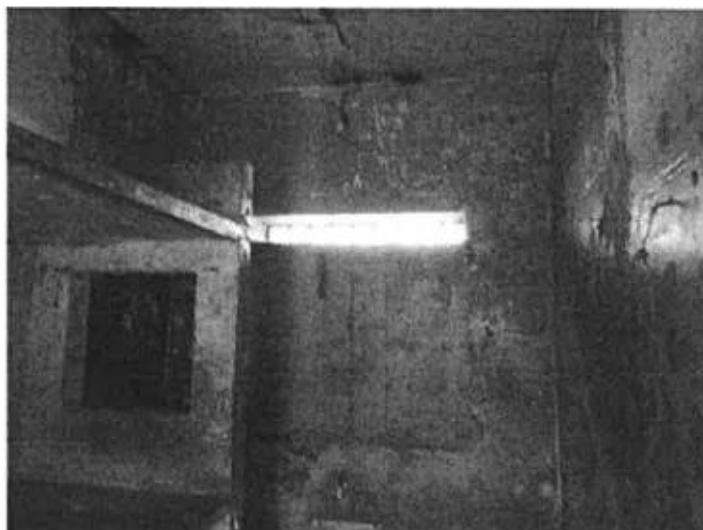
Imagem 3: interior de cela em reforma
