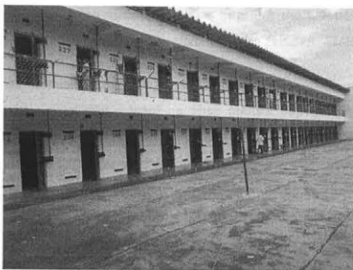
Imagem 2: interior do pavilhão em reforma
