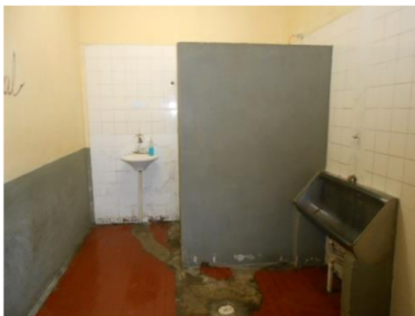
Banheiro das salas de aula
