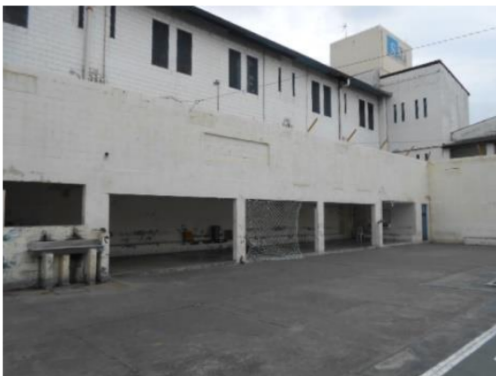
Área externa dos Pavilhões (revezamento)
