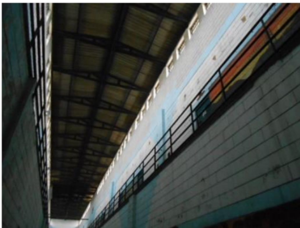
Telhado do corredor central e celas do pavilhão 2
