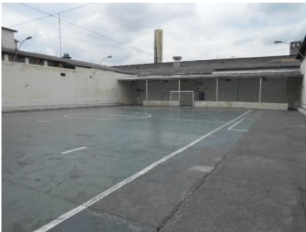
Área externa dos Pavilhões (revezamento)
