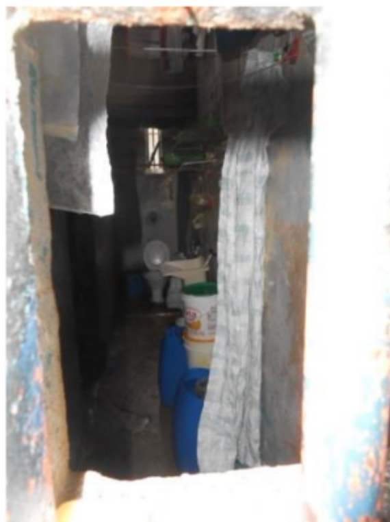
Banheiro da cela do setor de convívio (vaso sanitário ao fundo)
