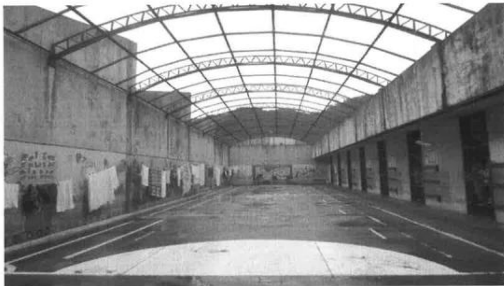
Área externa dos raios com quadra para prática de esportes.
