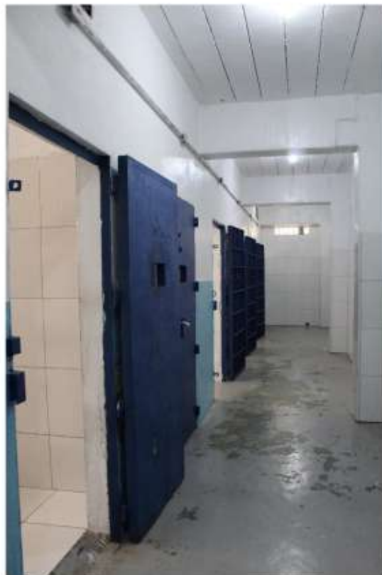
Corredor do setor de enfermaria com as entradas das celas
