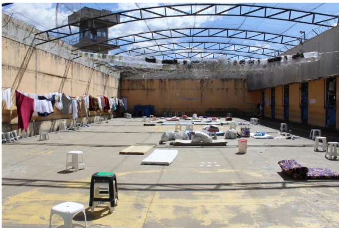
Foto geral de um dos raios do convívio (regime fechado)
