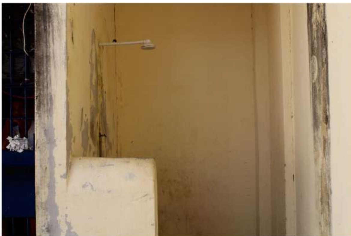
Área do pátio contendo chuveiro externo
