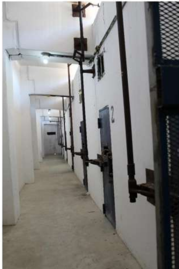
Corredor do setor de inclusão contendo a entrada das celas
