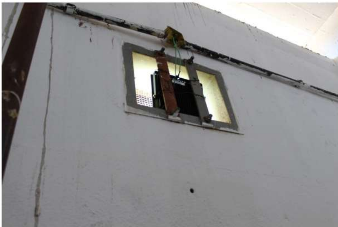
Detalhe para a iluminação vista pelo ângulo do corredor
