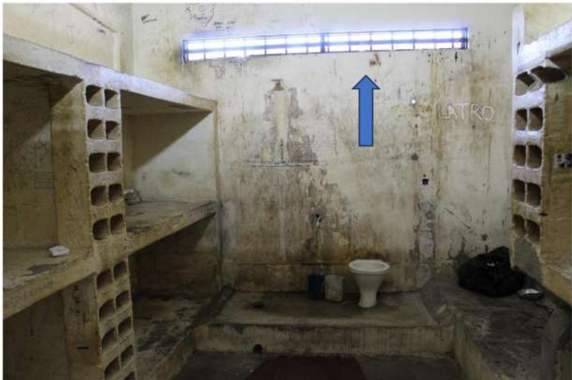
Interior de uma cela do setor disciplinar. Detalhe para o estreito espaço para passagem de ar na parte superior
