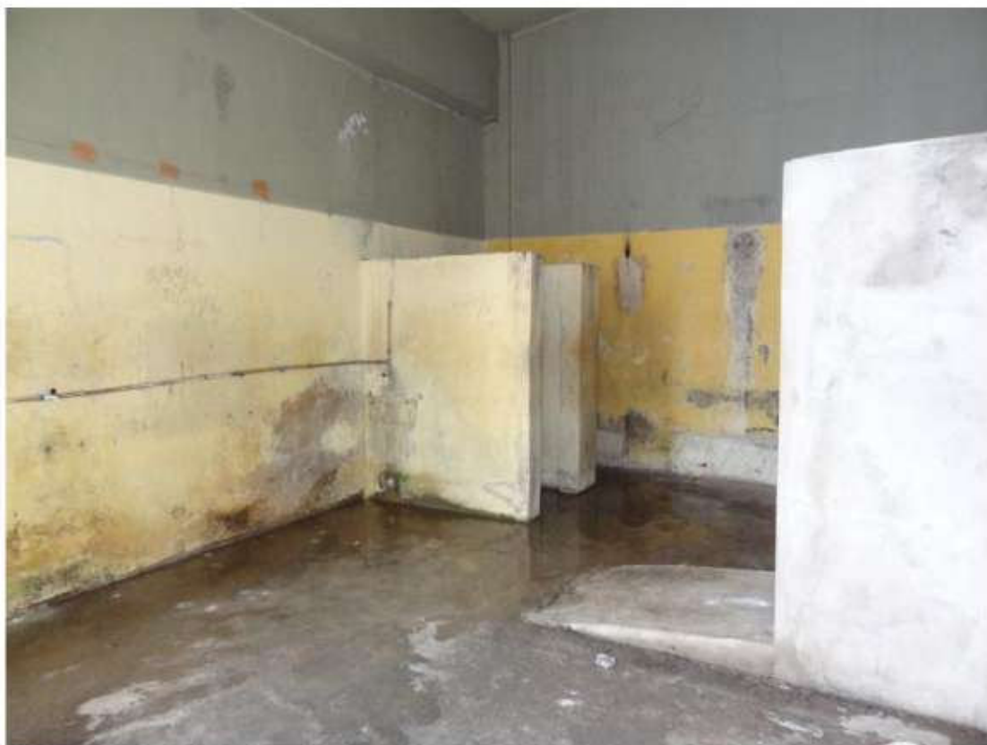
Espaço coletivo para banho – chuveiros aquecidos desativados
