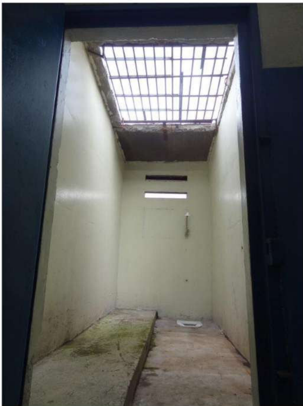
Cela transformada em solar para banho de sol dos presos do setor disciplinar, mas que, segundo os presos, não é utilizada
