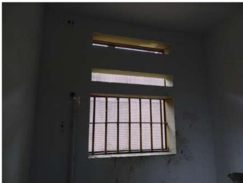
Aberturas gradeadas para a entrada de iluminação e ventilação
