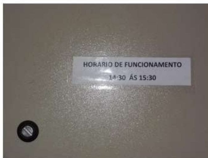
Comunicado de onde consta o horário de funcionamento do sistema de aquecimento da água
