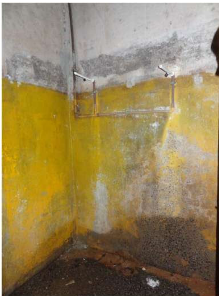
Chuveiros não aquecidos das celas comuns
