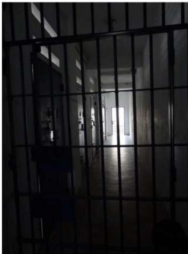
Entrada das celas do setor de enfermaria
