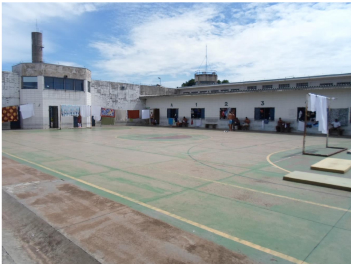
Figura 3. Pátio interno central, utilizado para o banho de sol e realização de atividades desportivas pelos presos.
