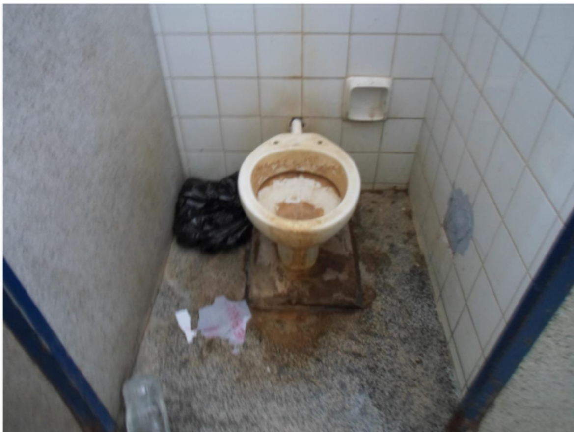
Figura 8. Instalações de um dos banheiros utilizados pelos presos.
