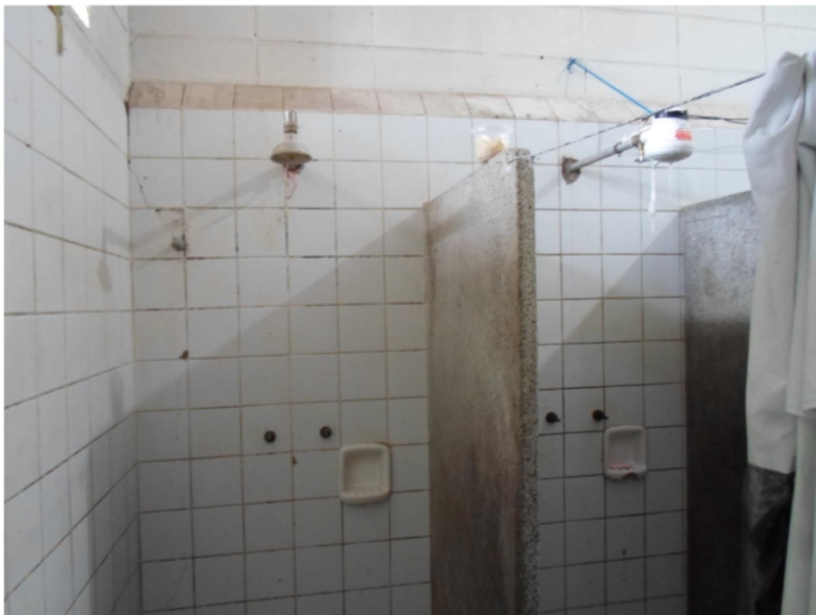
Figura 7. Instalações de um dos banheiros utilizados pelos presos.
