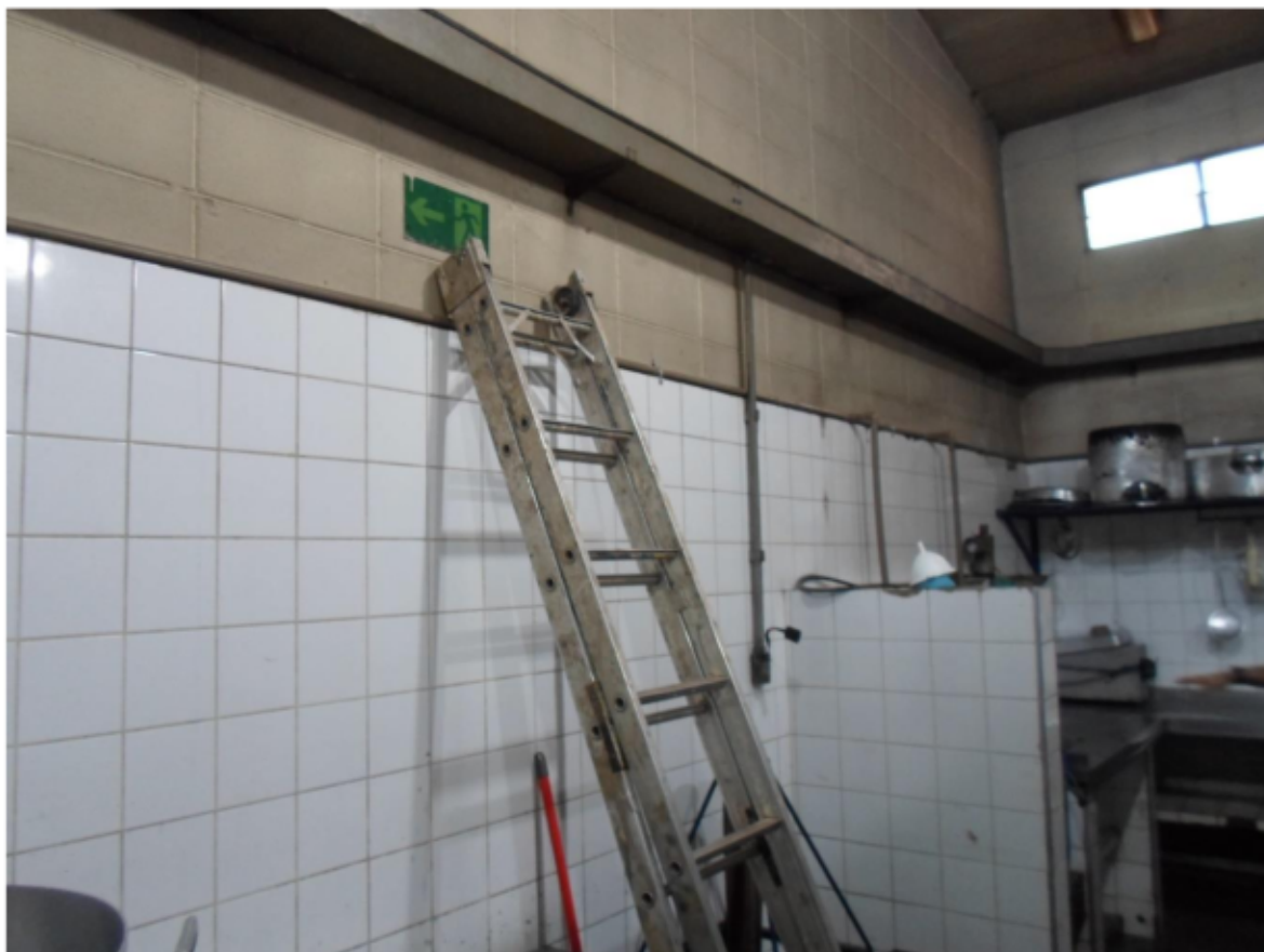
Figura 12. Reforma da cozinha central
