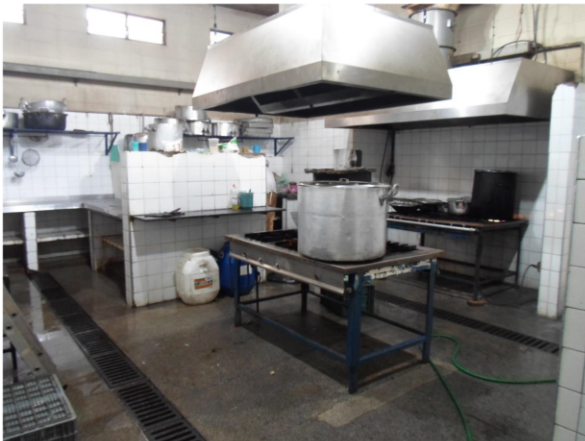
Figura 9. Cozinha central da unidade.
