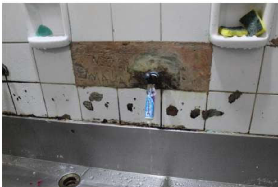
Destaque para torneira improvisada com tubo de pasta de dente
