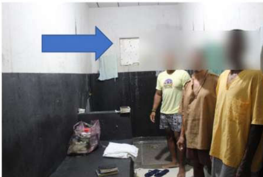
Foto de 3 presos isolados na cela 1 da enfermaria aguardando transferência. Destaque para a ausência de entrada de ar no fundo das celas
