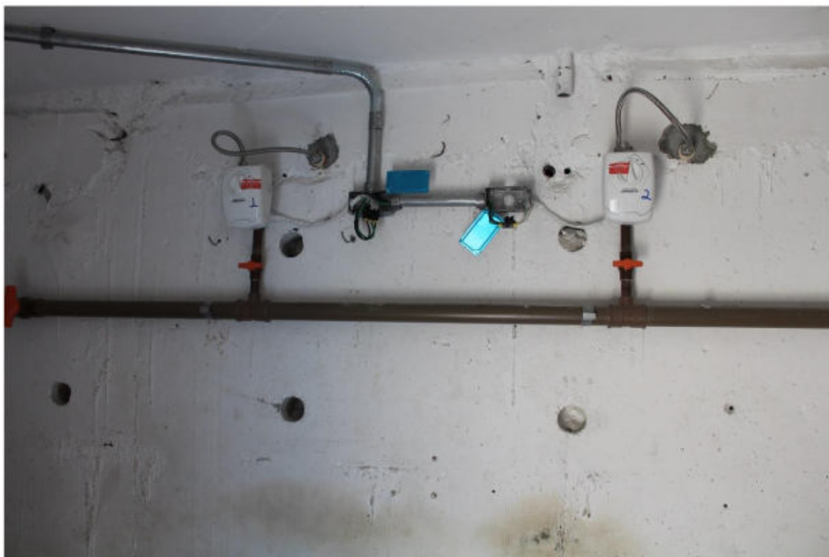
(foto do local em que estão sendo instalados os equipamentos de aquecimento de água – pelo lado de fora do raio)
