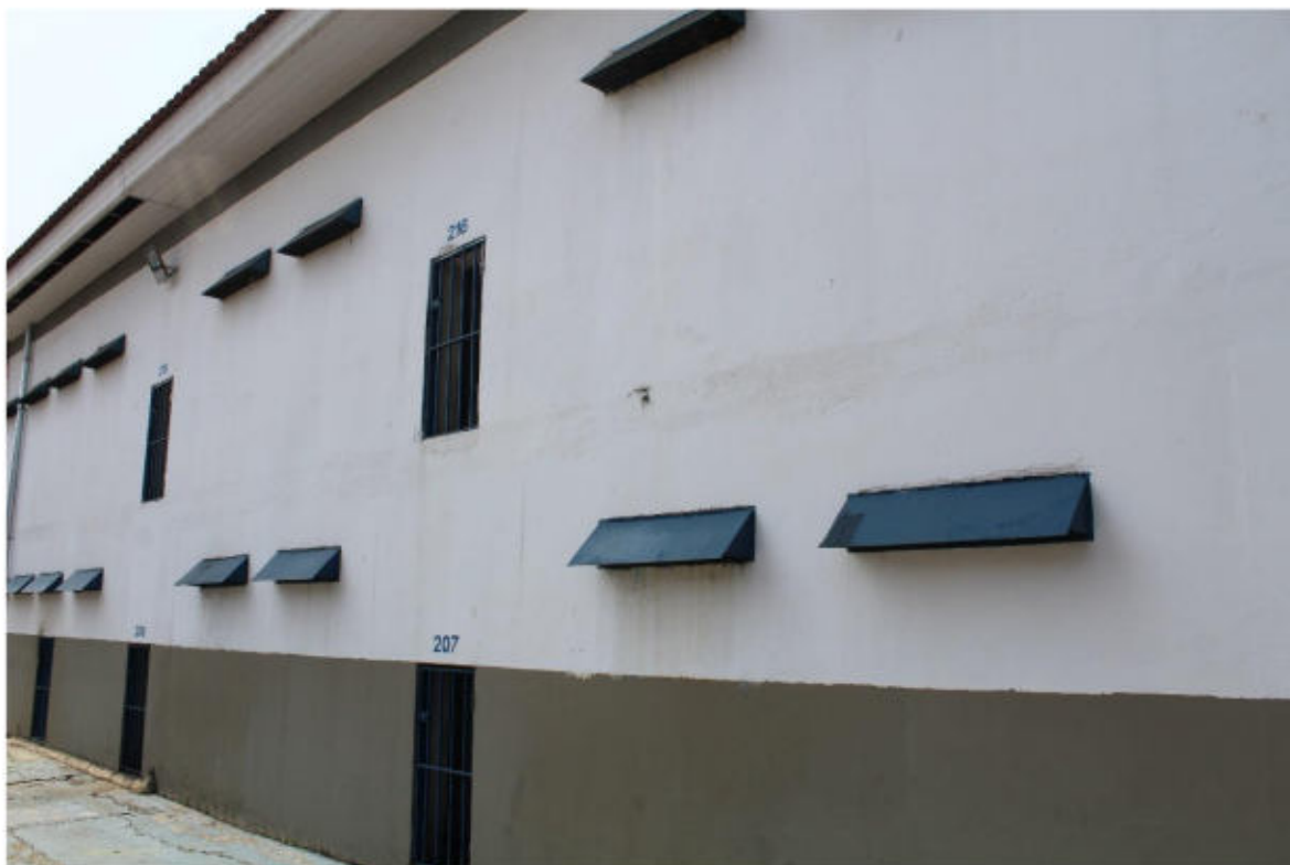
(vista externa das celas com as placas de metal recobrindo a entrada de ar)
