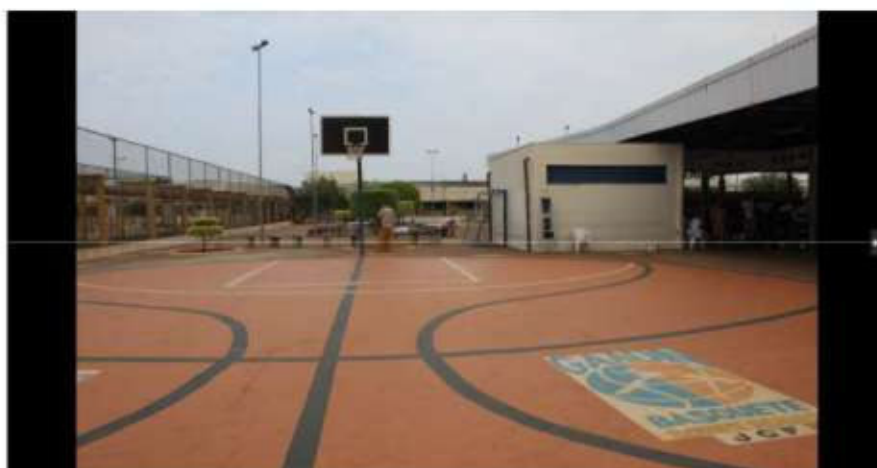
(Foto da quadra com revestimento no piso)
