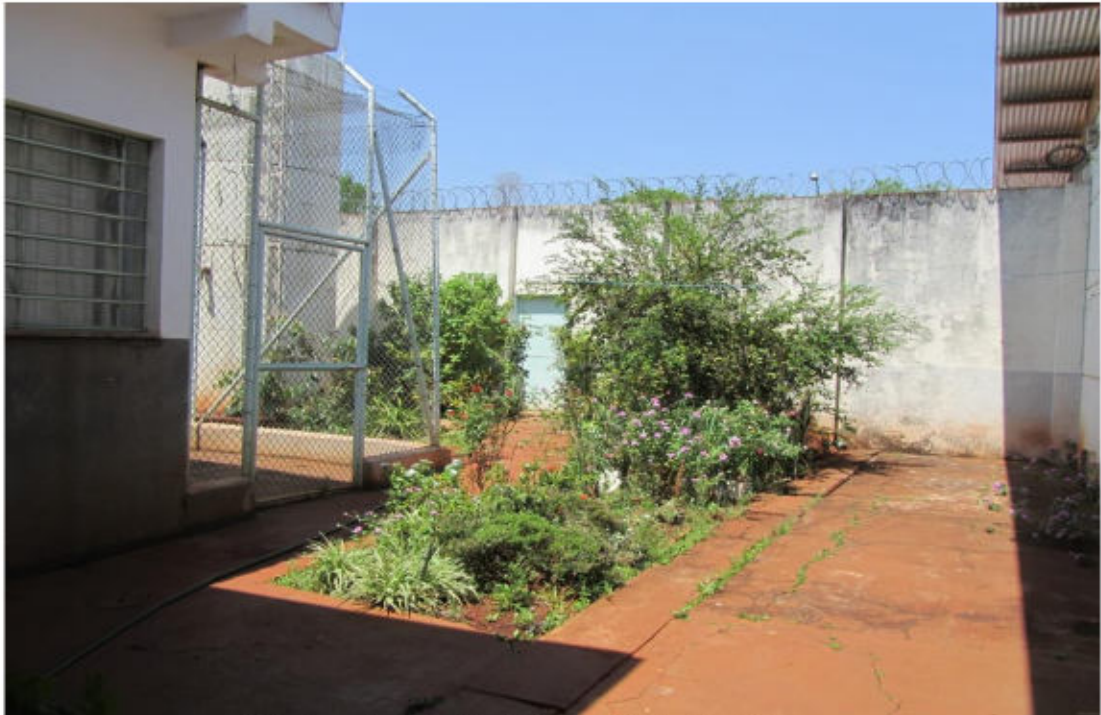
Foto da entrada da Ala de Progressão Penitenciária
