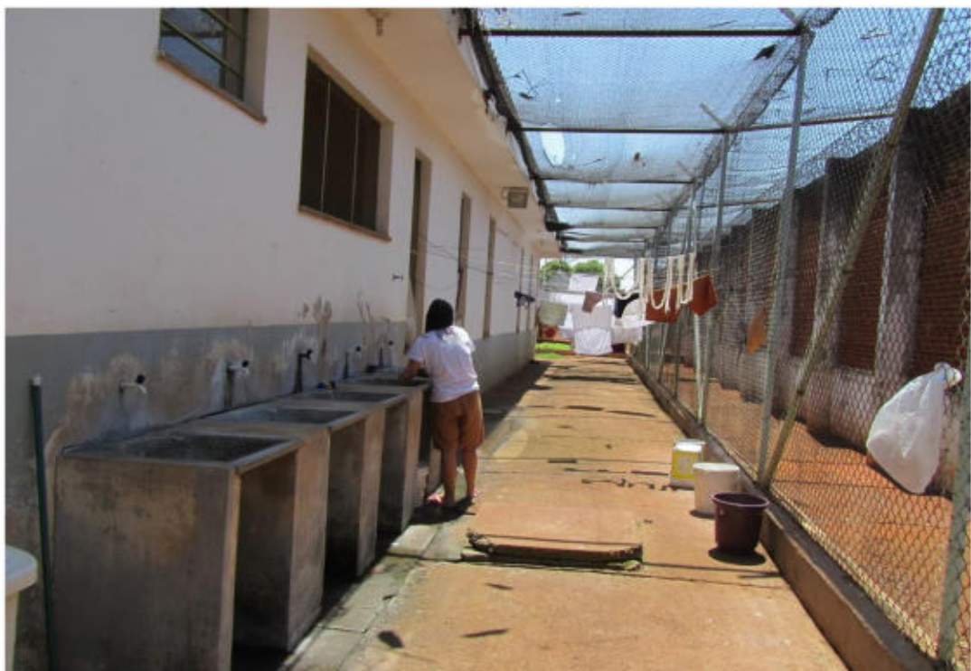
Foto lateral da Ala de Progressão
