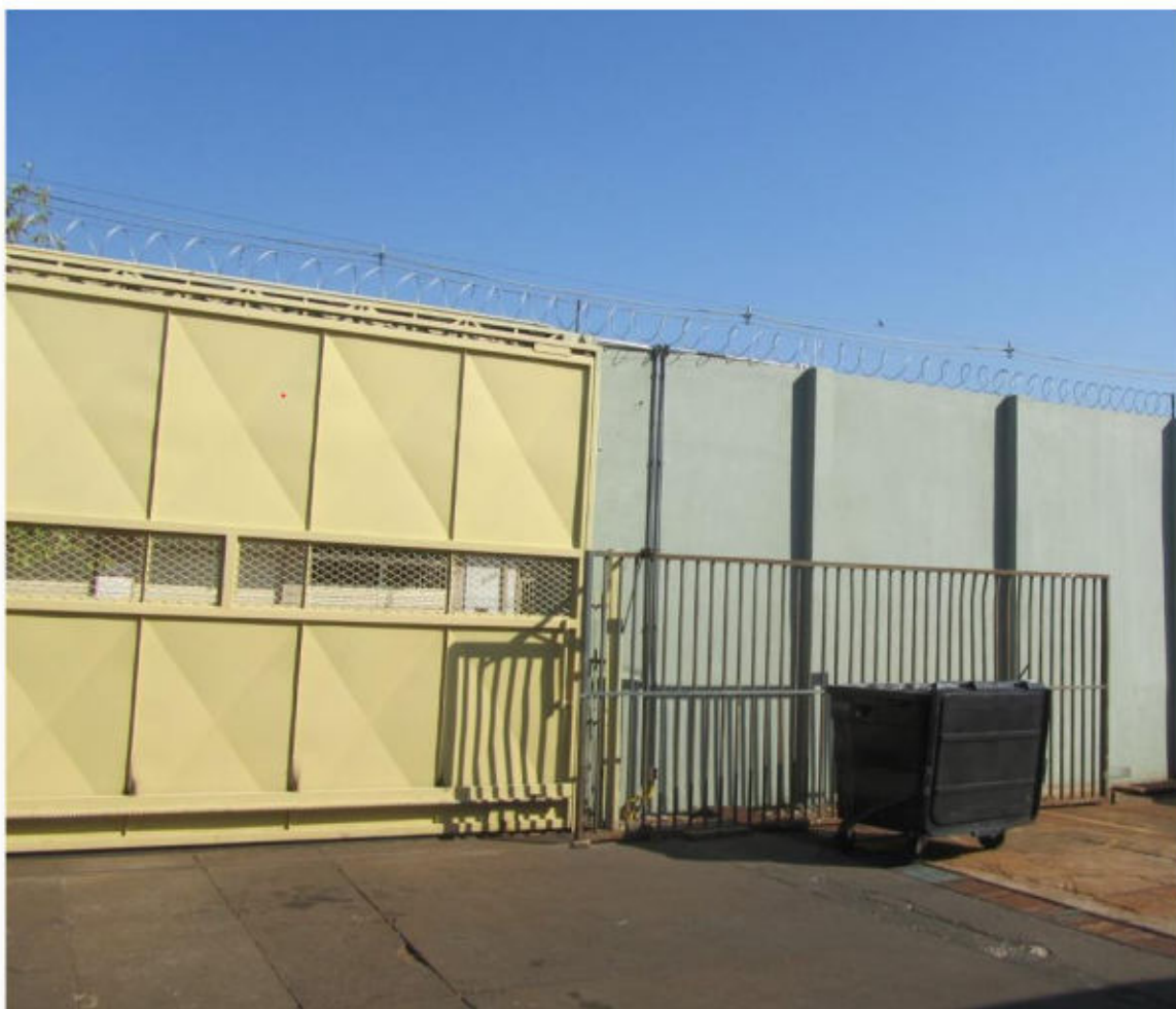
Entrada da Unidade (Portão Central de acesso à Pen. Feminina de Ribeirão Preto)
