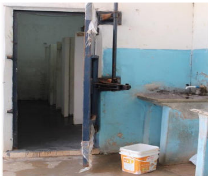
Foto da entrada do “banheirão”
