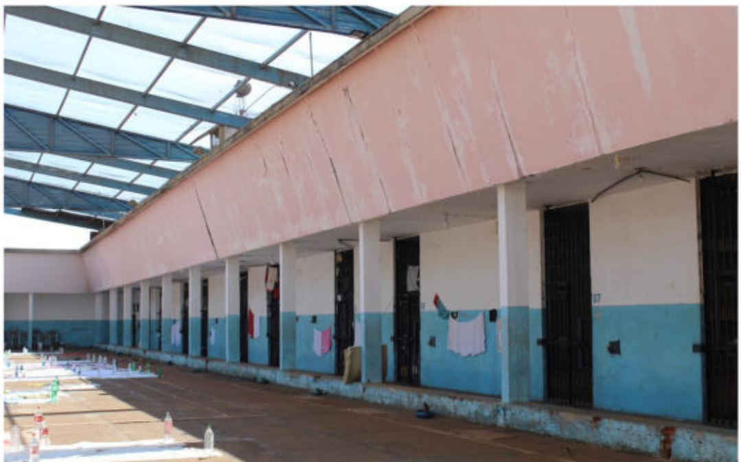
Foto externa das celas do Pavilhão Central
