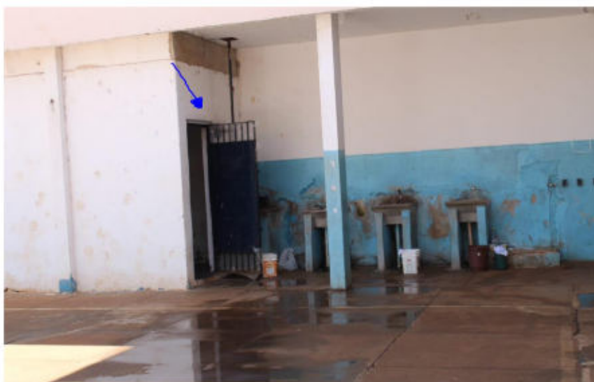
Foto da porta de acesso ao “banheirão” onde é disponibilizado o banho quente
