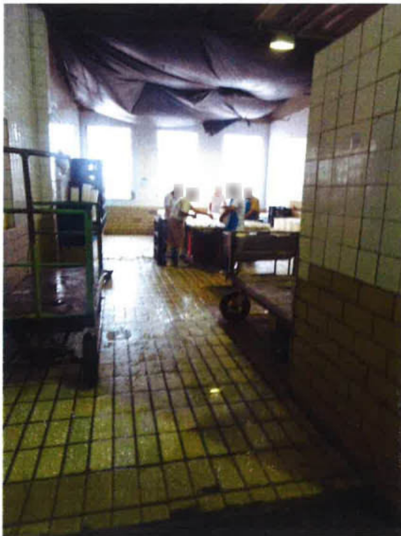
Detalhe da cozinha
