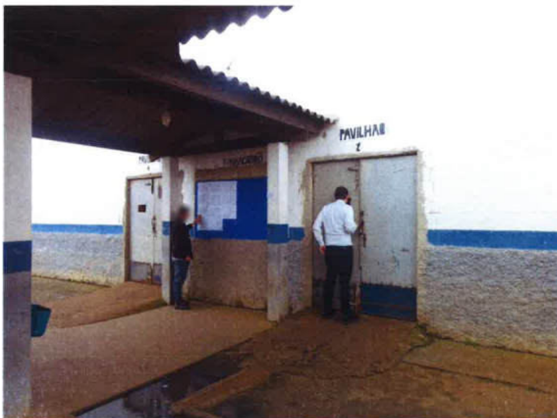
Vista externa dos pavilh
