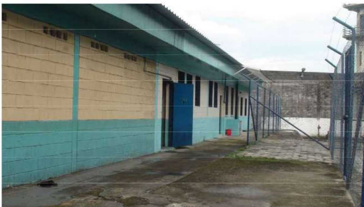
Acesso ao parlatório e à enfermaria
