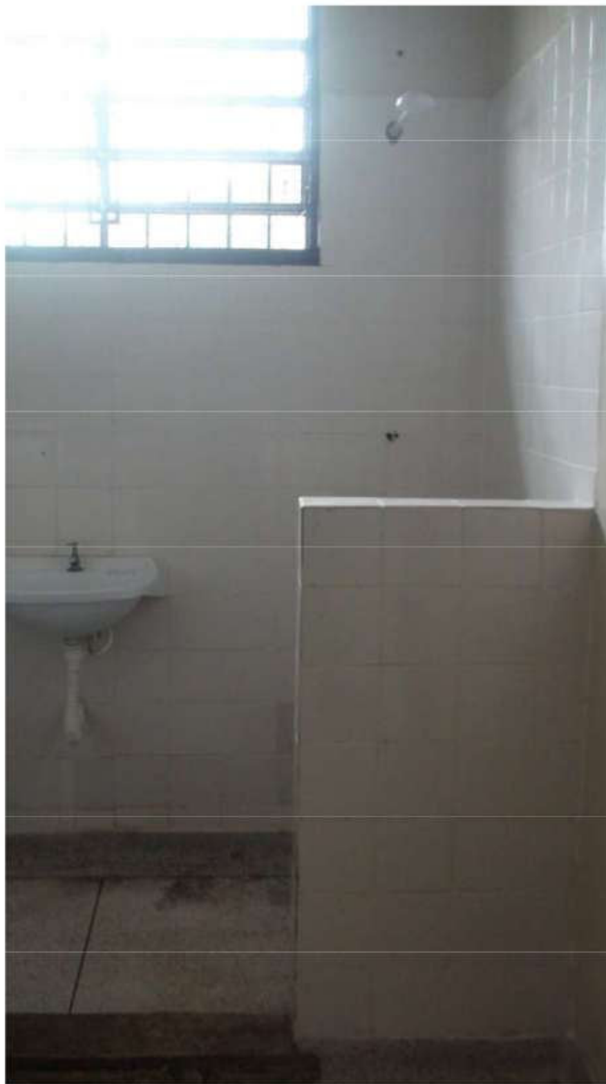
Banheiro da cela da enfermaria
