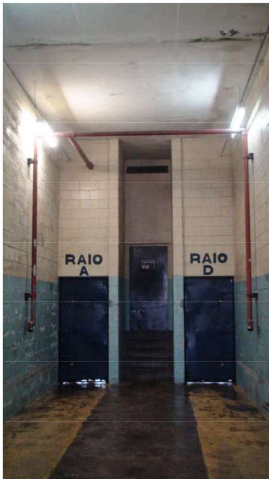
Corredor de acesso à gaiola e aos raios (radial)
