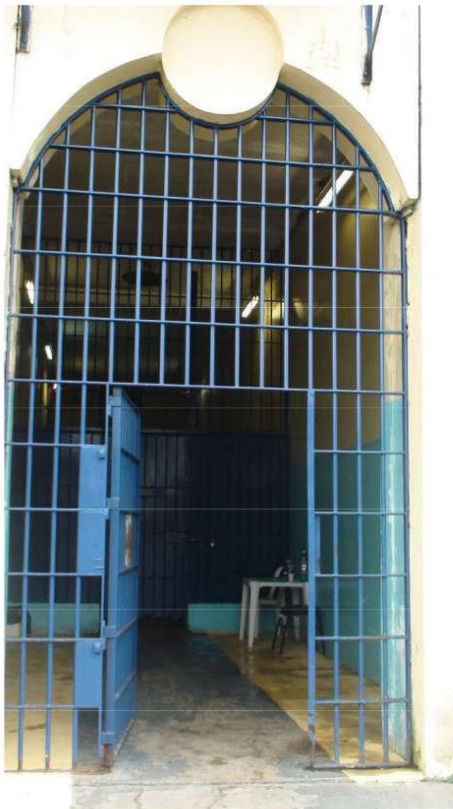
Entrada da parte interna da unidade (pavilhões habitacionais)
