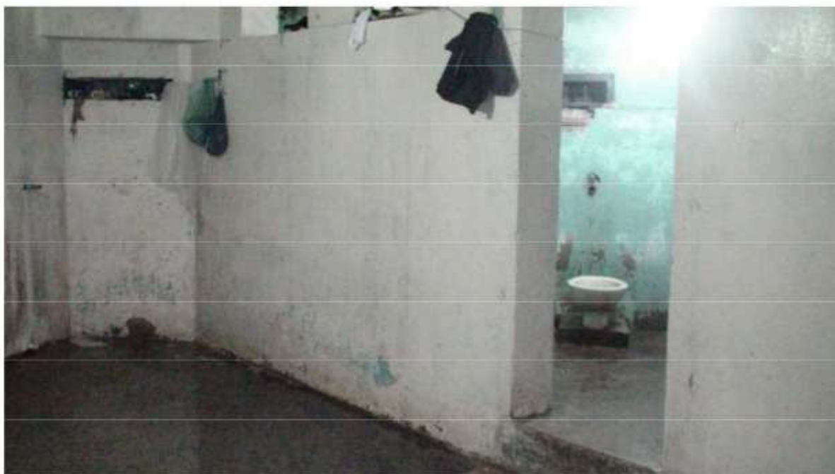
Área com vaso sanitário no interior do raio, usada pelas visitantes
