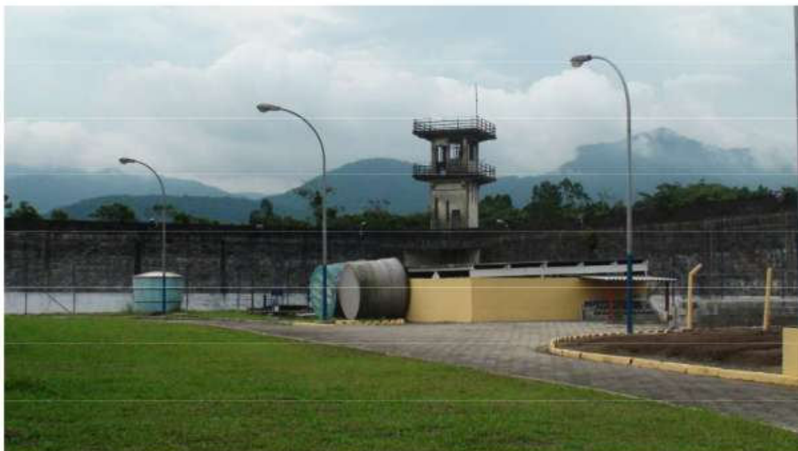
Parte externa, nos fundos do presídio, com caixas d'água
