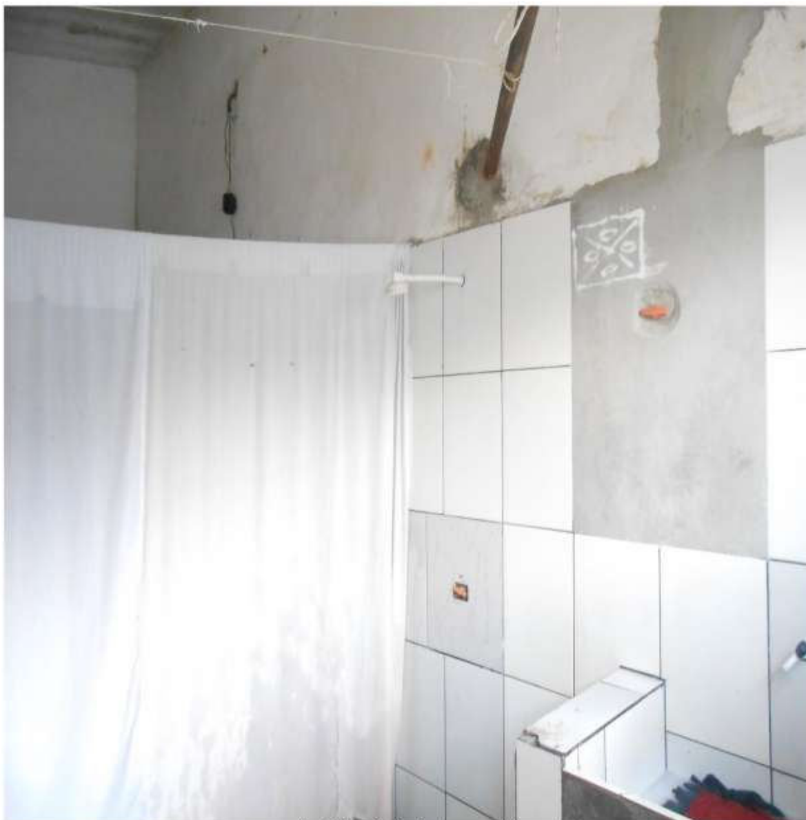
(banheiro da ala de progressão)
