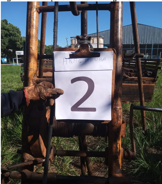
Figura 2: Execução do furo de sondagem SP-02
